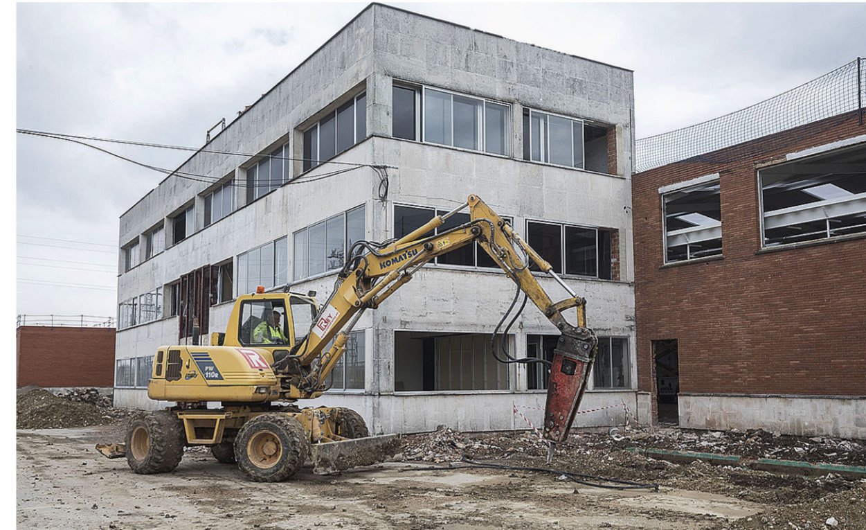
La labor de urbanización en los exteriores de la parcela, situada en López Bravo, ya ha arrancado.
